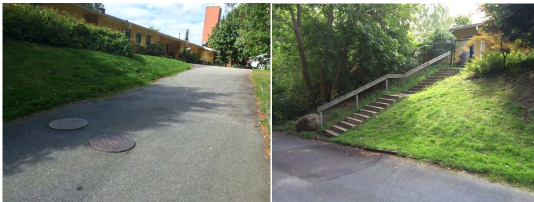
Bild 2 visar punkt 2 i översiktsbilden. Befintlig väg upp mot förskolan lutar från norr söder och väst till öst. Från vägen finns en trappa som går upp till förskoleentrén.
