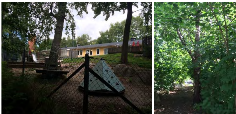
Bild 9 visar punkt 9, Förskolegårdens lutning är mot söder, med denna lekyta som lågpunkt. Därifrån sluttar även gångstigen söder om förskolan ner mot Kullegatan. Idag finns inga viloplan på vägen ner och stigen är i dåligt skick.
